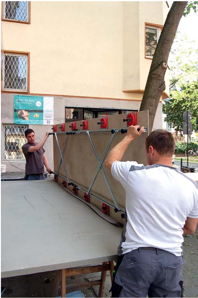
Ohne entsprechendes Hebezeug ist die Verlegung von großformatigen Fliesen kaum möglich. Die beiden Fliesenleger Daniel Stirmlinger und Wolfgang Fiegen nehmen im Bild die bis zu drei Quadratmeter großen Elemente mit einem Saugheber auf.
