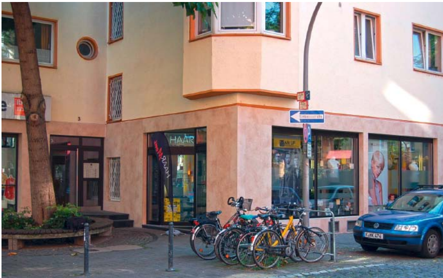
Neuland für den Kölner Fliesenleger-Meisterbetrieb Albert Kehr: Erstmals hat dessen Team großformatige Fliesen an einer Außenwand eingesetzt.
