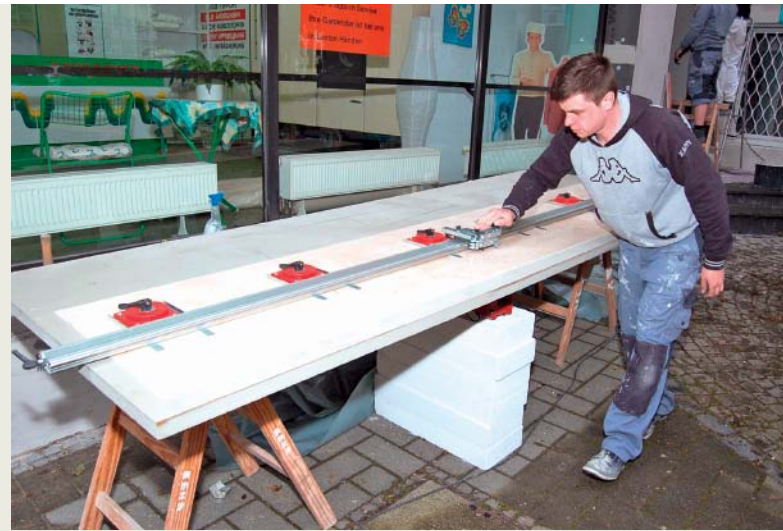
^ Für den Zuschnitt wurde ein Fliesenschneider mit langer Führungsschiene und Saugbefestigung benötigt.
