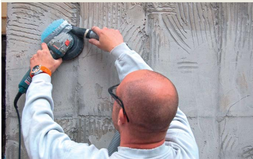
Großformatige Fliesen stellen hohe Ansprüche an die Ebenheit des Untergrunds. Daher wurde die Oberfläche zusätzlich abgeschliffen.
